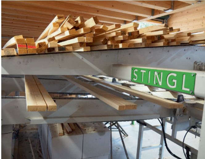
Hinter der Hobelanlage gibt es zwei Etagen – von unten rechts kommen die Querschnitte aus der Hobelung, die obere dient zum Zwischenpuffern
